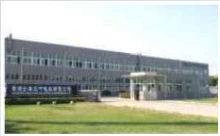
常州士林三葉電機(電裝品)
